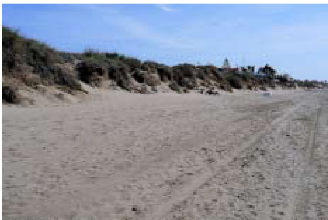
2.3 Playa de El Barronal con los taludes colgados y las alcantarillas al descubierto.
