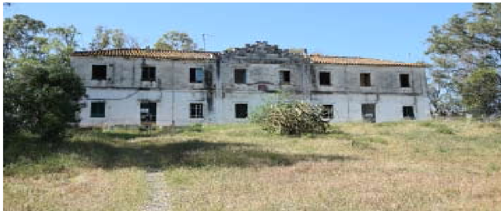
4.3 Casa Cuartel de la Guardia Civil de Real de Zaragoza.
