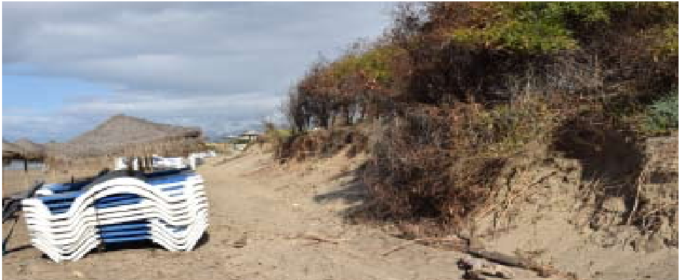
1.21 Vista del talud sobre la playa de la duna Las Golondrinas.
