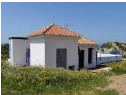
4.4 Estación de Impulsión (en duna Real de Zaragoza).
