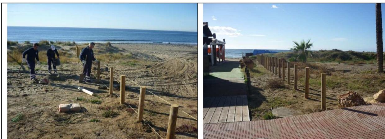
Según el entorno dunar y la necesidad visual y/o práctica, se preverá la colocación de estacas de madera con postes verticales de **1m (1,5m total) de longitud y de 10cm de diámetro**.
